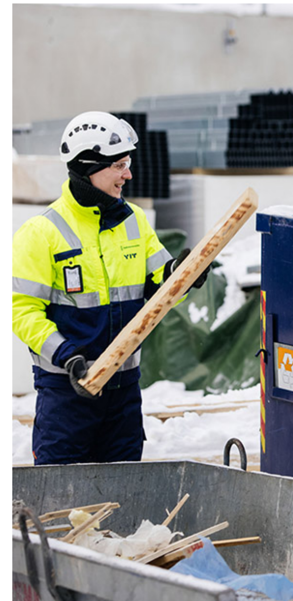
Lajittelua Asunto Oy Helsingin Birgerin työmaalla.
